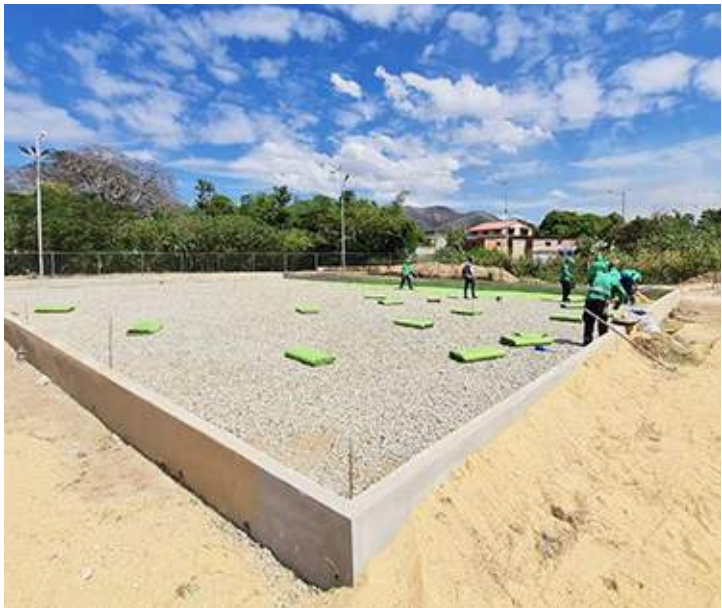
Iniciaron los trabajos de colocación de la grama natural. CORTESÍA
