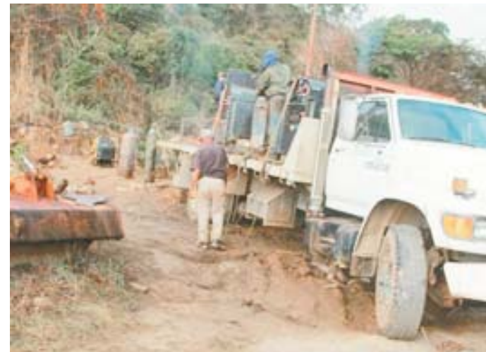
Reparación de tubería matriz en El Encantado
