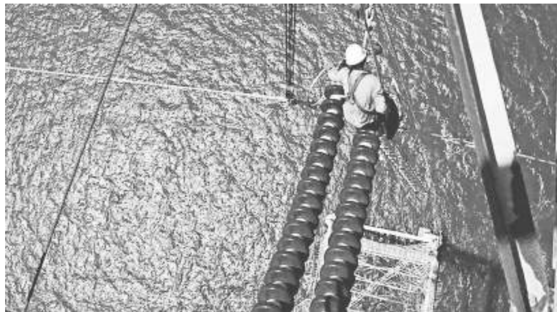
Este año una gabarra dañó el cable sublacustre de electricidad.. CORTESÍA
